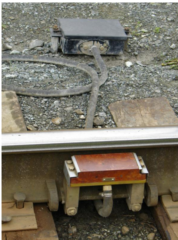
Рисунок 3 - Аппаратура счетного пункта
