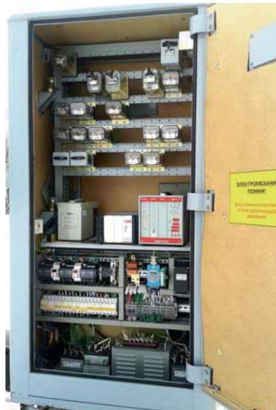
Релейный шкаф автоматической переездной сигнализации АПС-МП-М
