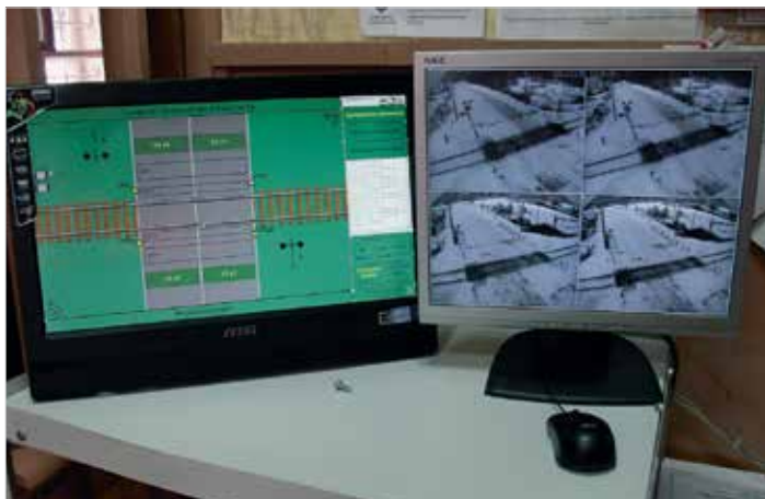
Мониторы АРМ дежурного оператора переезда
